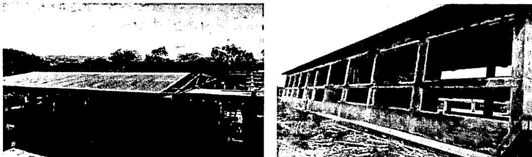
Figura N°4: Armado de techo con paneles de placa-yeso
