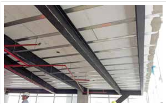
LAS VIGUETAS Y CASETONES SE APOYAN SOBRE LA ESTRUCTURA
